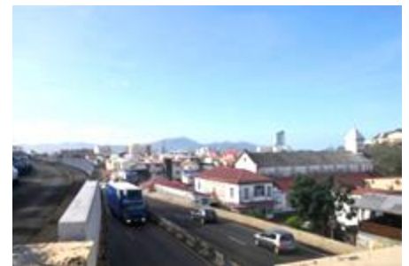
boulevard Patrice LUMUMBA à Fort-de-France
