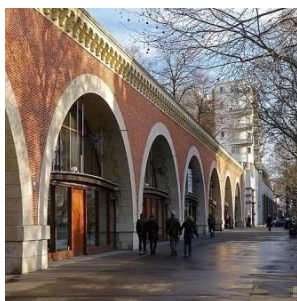
Viaduc avenue Daumesnil Paris XII ème
